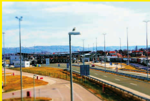
Granični prijelaz Obrežje – Bregana
